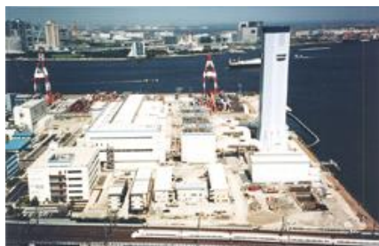
(東京電力 品川火力発電所)
