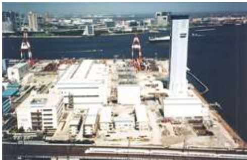
(東京電力 品川火力発電所)
