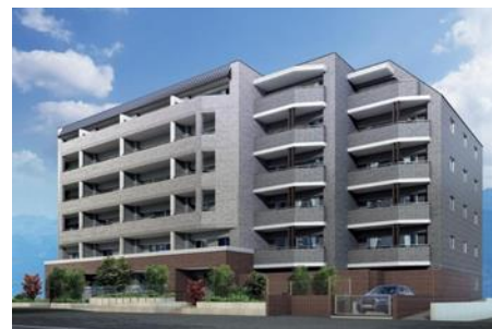
ワコーレ新神戸ステーションリブリエ 神戸市中央区、総戸数 33 戸 神戸市営地下鉄「新神戸」駅徒歩 6 分 2019 年 11 月引渡予定
