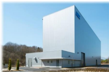
● 福島工場 総合防災研究棟
