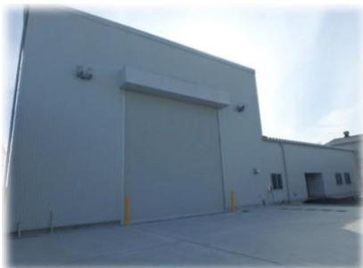
● 千葉工場 新研究棟
