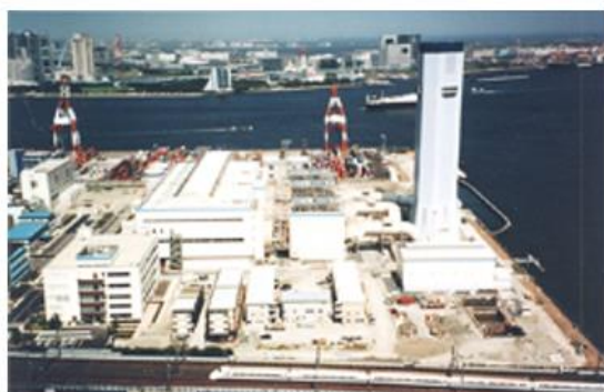
(東京電力 品川火力発電所)
