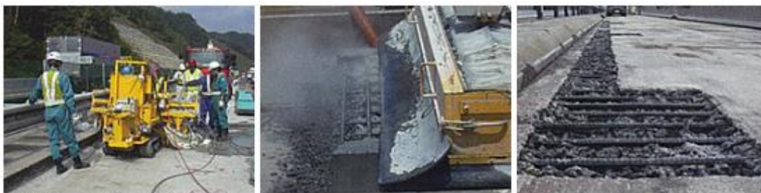
コンクリート床板塩害劣化部除去
