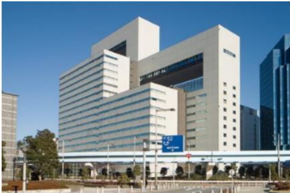
お台場オフィスが入居するタイム24ビル外観
