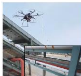
JSR 配管点検
