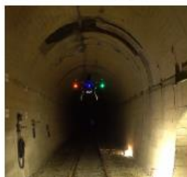
JR北海道 トンネル点検
