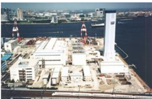
(東京電力 品川火力発電所)
