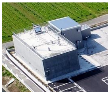
(株)ピックルスコーポレーション西日本・佐賀工場の排水処理施設 (同社資料より)
