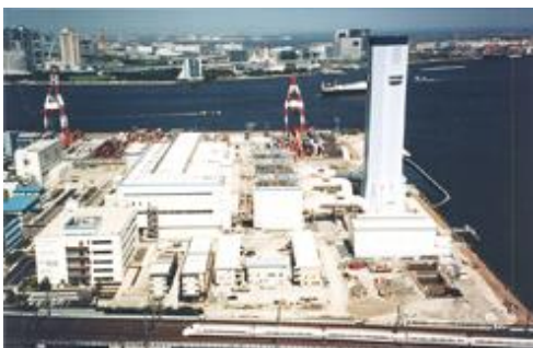
(東京電力 品川火力発電所)
