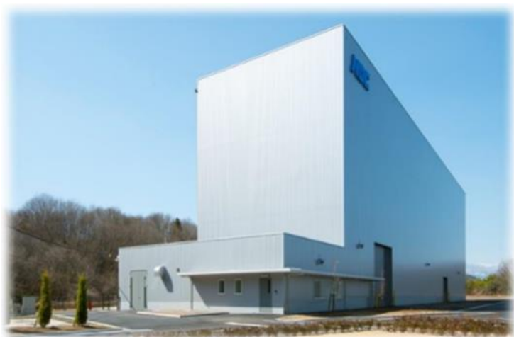
福島工場 総合防災研究棟
