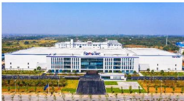
安徽省銅陵市内に建設した再生ウエーハ工場
