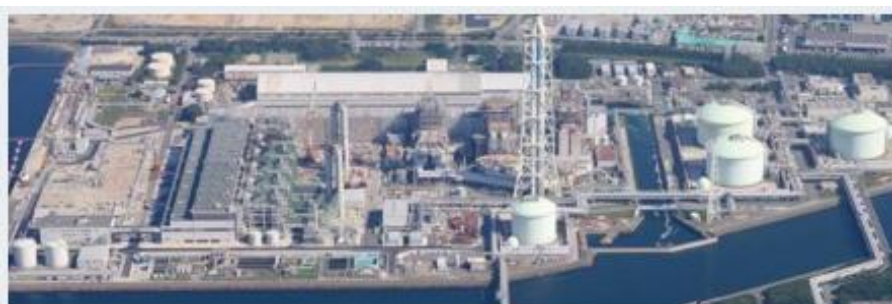
火力発電プラント
