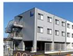
住宅型有料老人ホーム リーガテラス南草津
