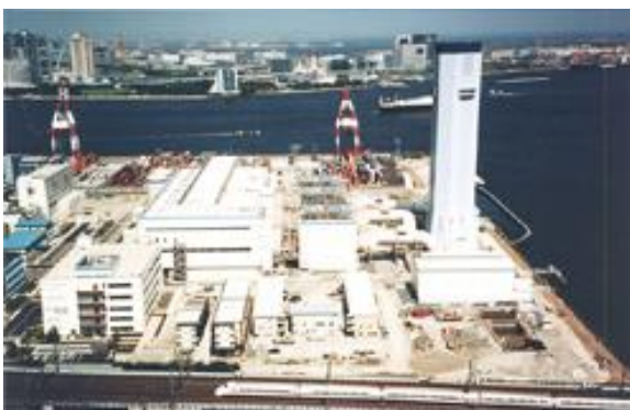
(東京電力 品川火力発電所)
