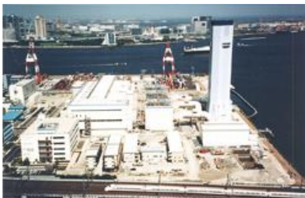
(東京電力 品川火力発電所)
