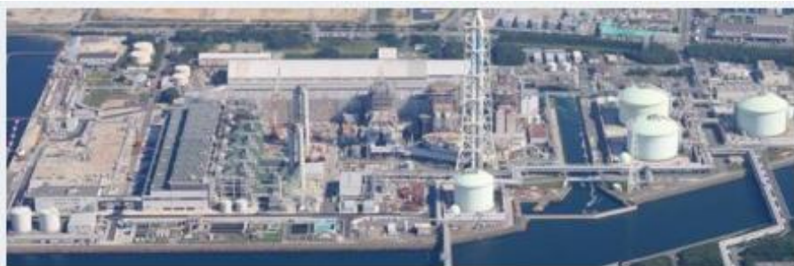
火力発電プラント
