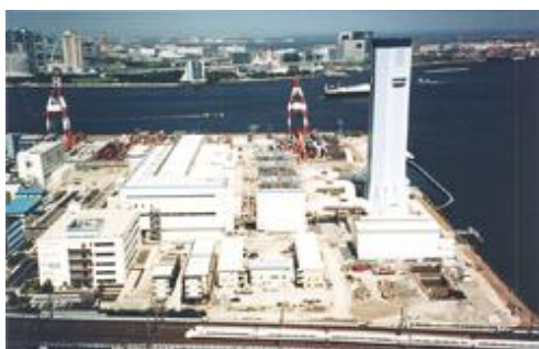
(東京電力 品川火力発電所)
