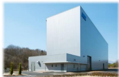
福島工場 総合防災研究棟
