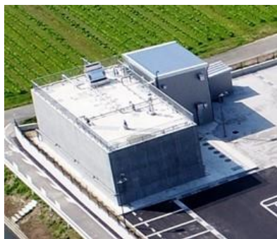
(株)ピクルスコーポレーション西日本・ 佐賀工場の排水処理施設 (同社資料より)
