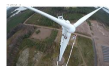
風力発電施設の保守・メンテナンスで使用
