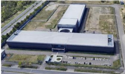
▲石狩データセンター空撮（手前：1・2号棟、奥：3号棟）
