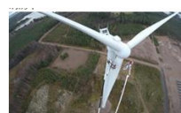
風力発電施設の保守・メンテナンスで使用
