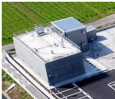
(株)ピクルスコーポレーション西日本・ 佐賀工場の排水処理施設 (同社資料より)
