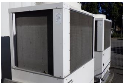
(株)ピクルスコーポレーション・所沢工場のCO2冷媒の空調機器 (同社資料より)
