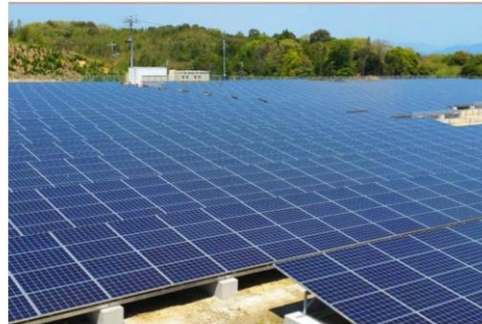
利用面積24,320㎡・パネル出力約1.3MWhにて 2024年5月期は当社グループ消費電力量の約4.4倍 となる1,356MWh発電
