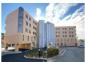
一休西宮 62室 (旧社員寮) (2023年1月26日竣工)
