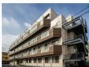
ヒビオ住吉 78室 (旧病院) (2025年2月3日竣工)
