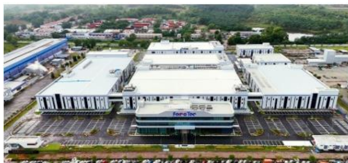
クリム第一工場(マレーシア)
