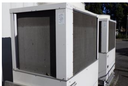
(株)ピックルスコーポレーション・ 所沢工場のCO2冷媒の空調機器 (同社資料より)
