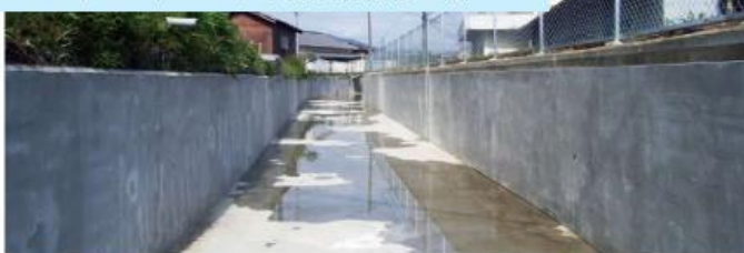
ASモルタル工法
