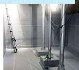
パネ支柱工法
