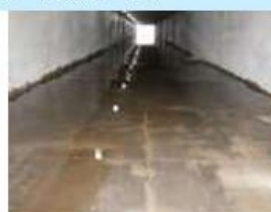
ダクトアルパネルライニング工法
