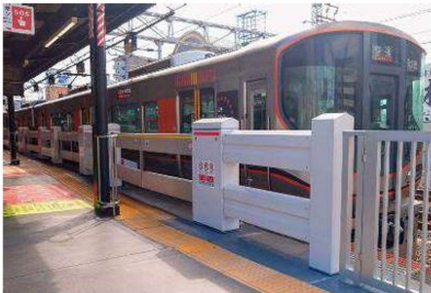
改良型可動式ホーム柵 JR西日本・㈱JR西日本テクシア・ナブテスコ㈱共同開発
