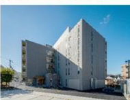
ヒビオ住吉 78室 (旧病院) (2025年2月3日竣工)
