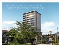
ブランドード河内永和 13F 38邸 RC造 (2024年5月17日竣工)
