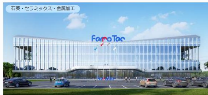
マレーシア・クリム第2工場
