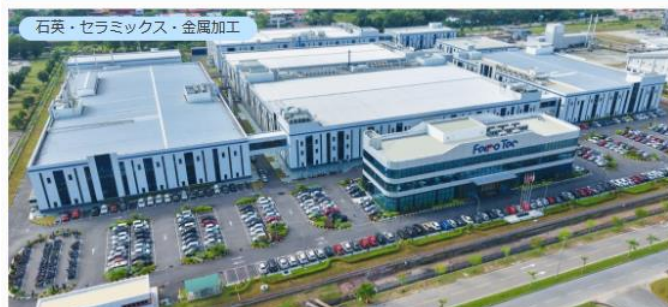
マレーシア・クリム第1工場
