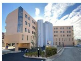
一休西宮 62室 (旧社員寮) (2023年1月26日竣工)
