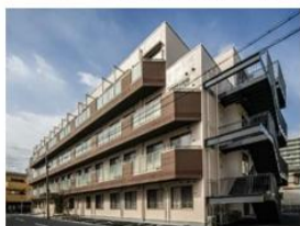
ヒビオ住吉 78室 (旧病院) (2025年2月3日竣工)
