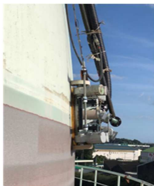
左：ブラストマシン 中・右：マシンがガスホルダーの外周を自動で水平に周回、均一かつ効率的な施工を実現
