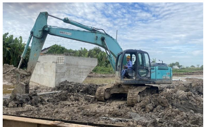
サムシングベトナムに就職し、ドン・タップ省の道路工場の現場で活躍しているサムシングの元技能実習生
