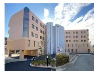
一休西宮 62室 (旧社員寮) (2023年1月26日竣工)
